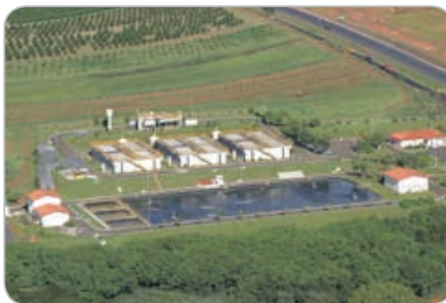
Estação de tratamento de esgoto Piracicamirim
